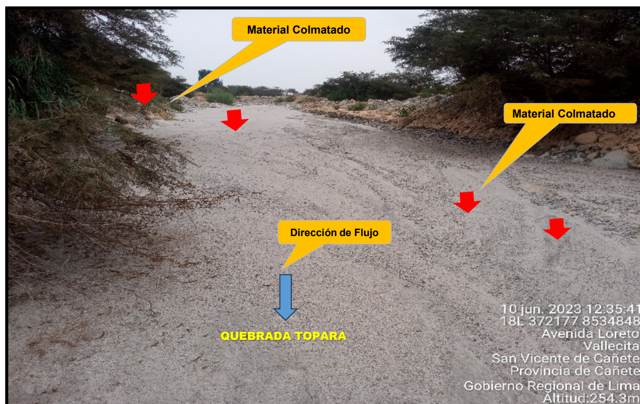
FIGURA N°03: EN LA TEMPORADA DE MAXIMAS AVENIDAS, LA QUEBRADA TOPARA, SE COLMATA A LA ALTURA DEL SECTOR ALGARROBO.
